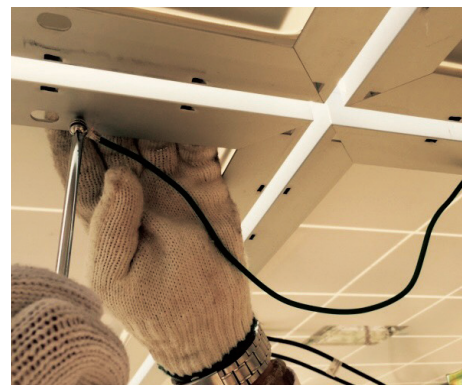
アースの取り付け コスト: 約400円/KW(現場取付費)
